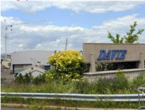
Une partie des installations de la Davie. © Les archives Daniel Mallard
