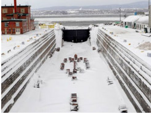
La cale sèche du chantier sous la neige (Photo: Agence QMI)
